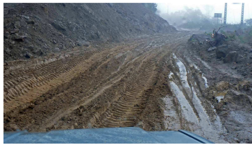
Schlamm bei den Baustellen
