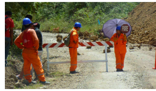
Sonnenschutz nach Erdbeben
