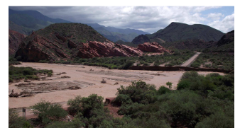
Fluss spült Straße weg
