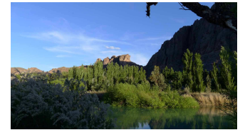
unterhalb der Staumauer
